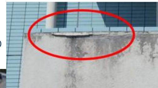
屋外階段の手すり部分のひび割れ
