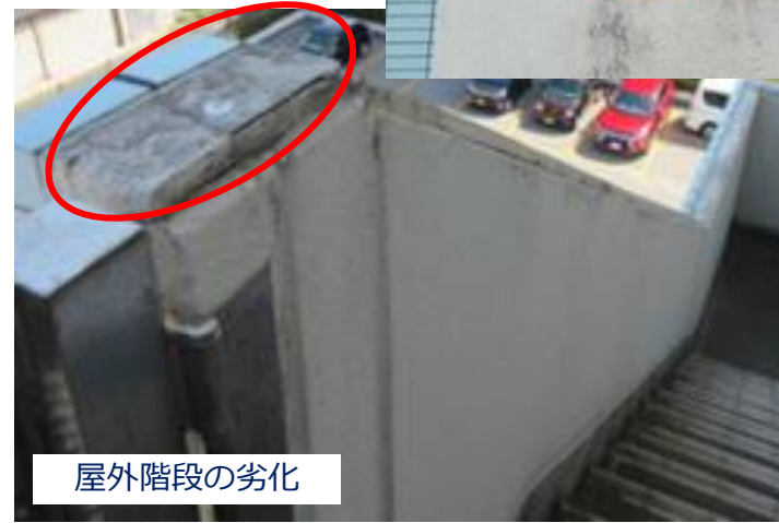
屋外階段の手すり部分のひび割れ
