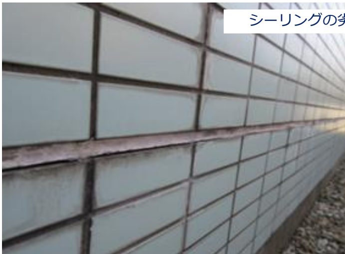
雨水などがコンクリート内に侵入した跡
