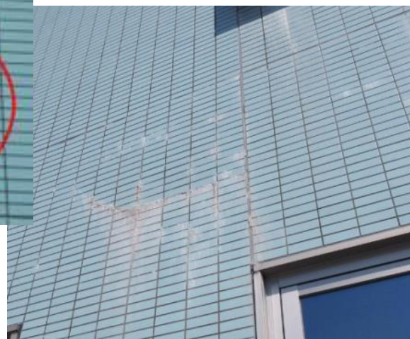
雨水などがコンクリート内に侵入した跡
